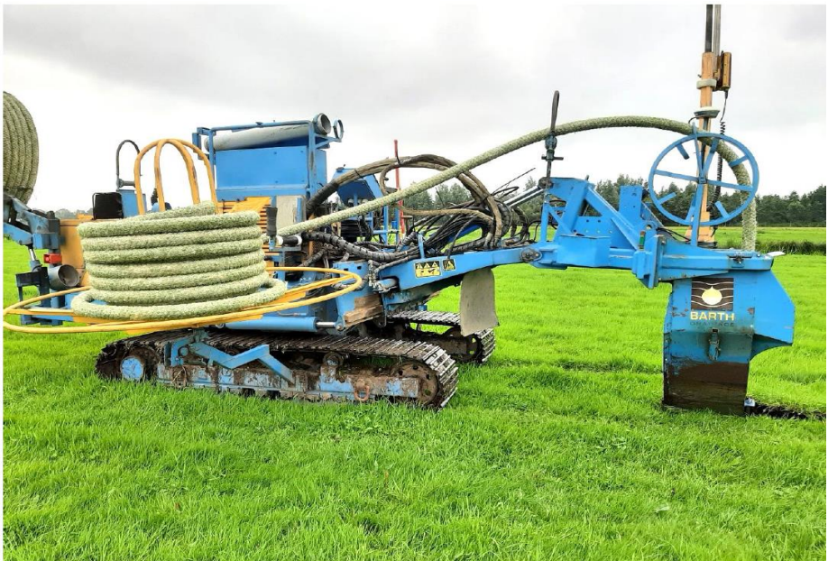
De drains werden sleufloos in de bodem aangelegd door Barth drainage.
